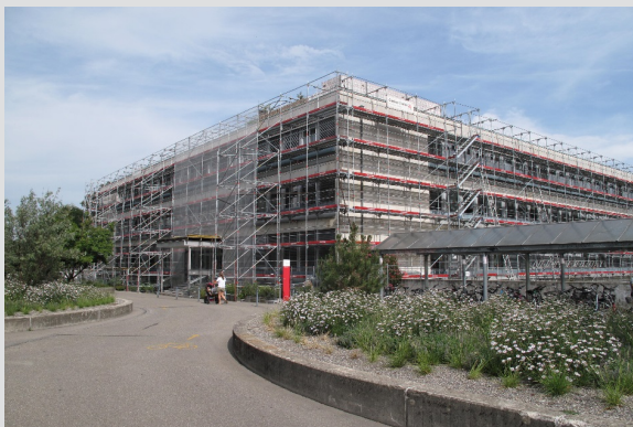
Sidlerstrasse 5 , 2018-2020; Sanierung und Laborbereitstellung Exakte Wissenschaften
