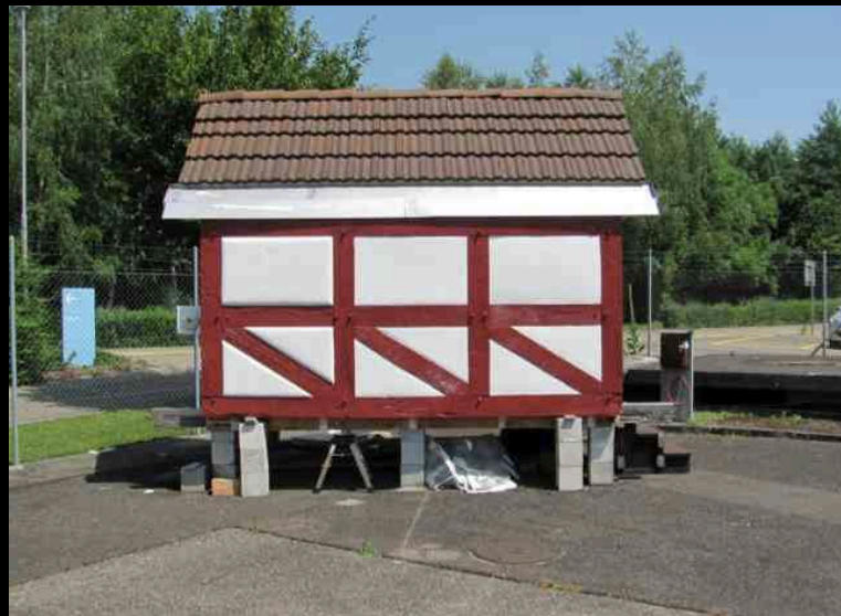
Strategie 5: moderne Technologien nutzen: Aerogel-Hochleistungsämmputz Hohe Isolationsfähigkeit (vergleichbar mit Polystyrol-Platten)
