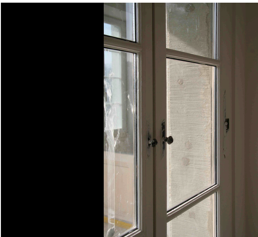
Strategie 3: Aufrüsten der bestehenden Fenster: Junkerngasse Bern historisches Fenster nachgerüstet mit Isolierverglasung
