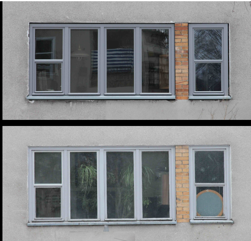
Strategie 3: Aufrüsten der Fenster: Siedlung Siemensstadt Berlin Extremfall: Ersatz von bauzeitlichen Fenstern
