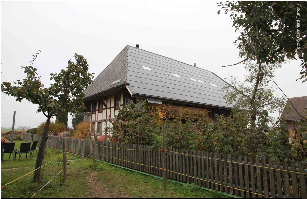
Strategie 6: Solaranlagen dort, wo sie verträglich sind: Bauernhaus in Uetligen vollflächige Photovoltaik-Anlage auf der Südseite des Daches
