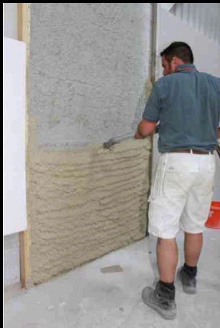
Strategie 5: moderne Technologien nutzen: Aerogel-Hochleistungsämmputz Hohe Isolationsfähigkeit (vergleichbar mit Polystyrol-Platten)
