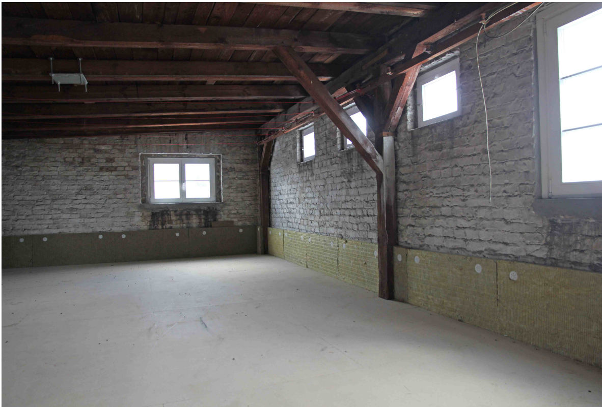
Strategie 2: Wärmedämmung unten und oben: Hufeisensiedlung Britz, Berlin Wärmedämmung der Estrichdecke
