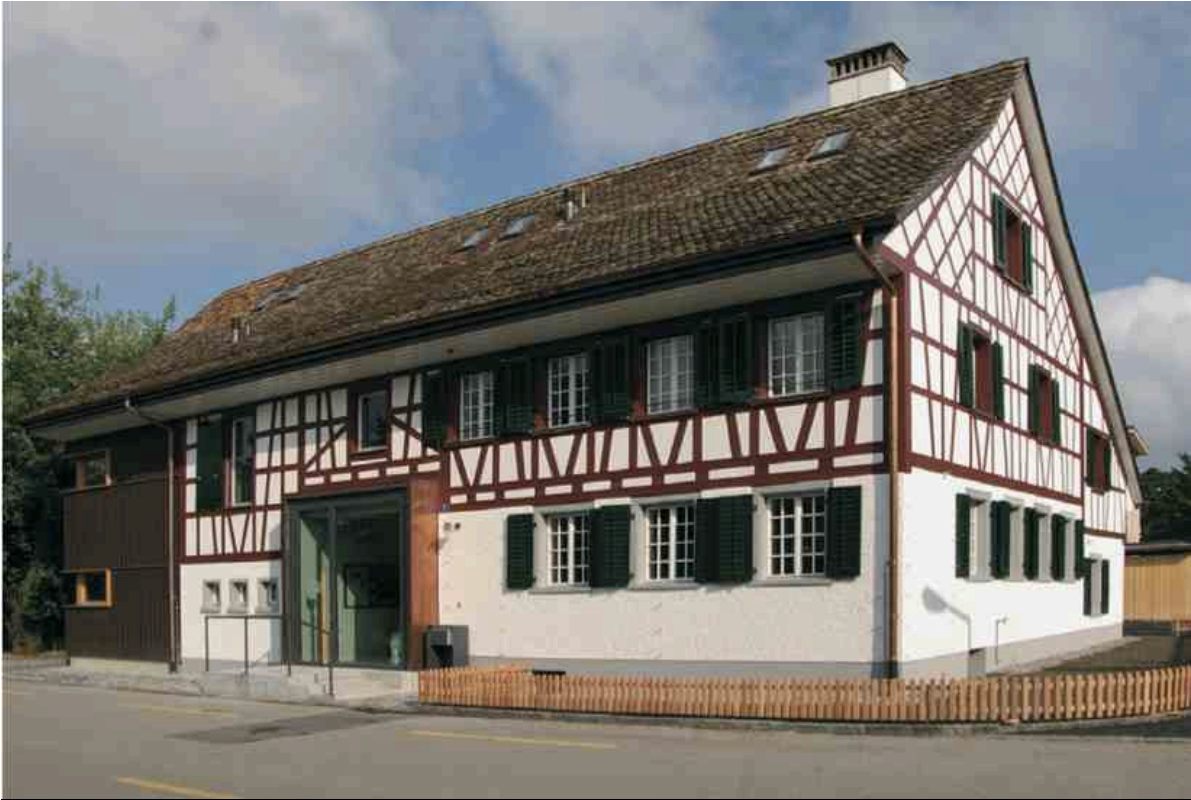
Strategie 2: Wärmedämmung unten und oben: "Freitaghaus" Winterthur Keine Eingriffe an Fassaden und Dach
