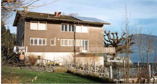
63 m<sup>2</sup> Photovoltaik-Zellen liefern Wasserstoff für eine Reichweite von **13'000 km / Jahr**
