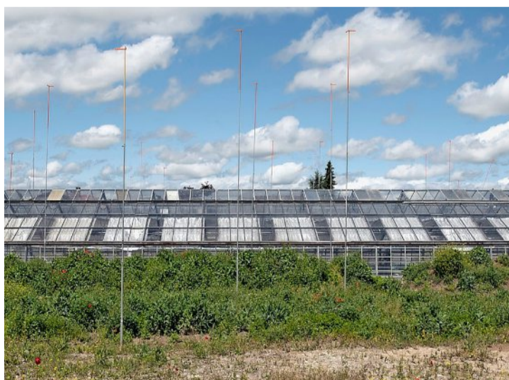
Die Profile für den Bau stehen schon seit einiger Zeit. Foto: Beat Mathys
