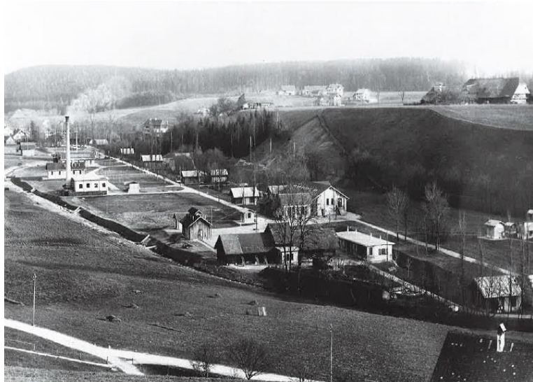
Eidgenössische Kriegspulverfabrik, um 1891, Blick nach Südosten
