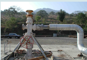
...mit Hilfe eines Bohrlochs...
