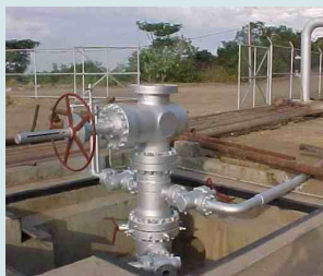
einer Verpressbohrung für das gekühlte Wasser, ...
